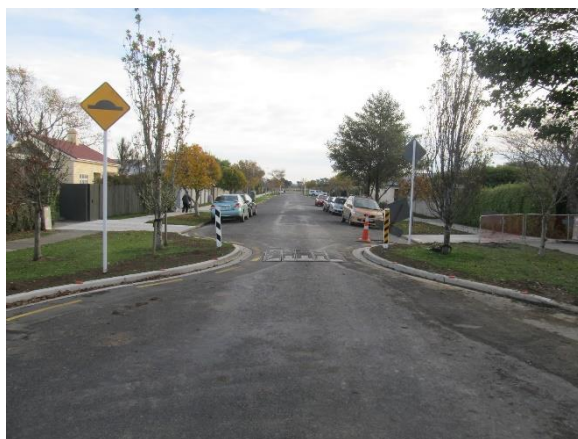
Слика 45 Пример сужења коловоза у зони пешачког прелаза 17
