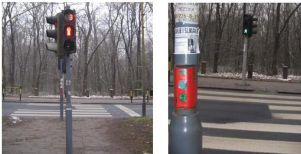
Слика 54 Пример пешачке лантерне са најавом пешака
